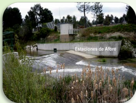
Estación de aforo tipo V-Flat
